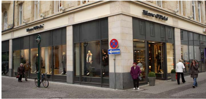
Bild 13: Heidelberg, Hauptstraße 90 – Wie wichtig die Farbe von Schriftzügen für deren Integration in die Fassade ist, wird beim abgebildeten Gebäude deutlich. Schriftzug und Schaufensteranlagen haben den gleichen Farbton und unterstützen auf diese Weise die Ganzheitlichkeit der Fassade.
