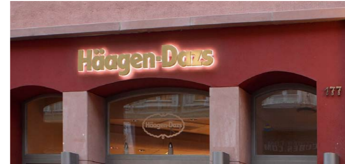
Bild 9: Heidelberg, Hauptstraße 177 – Hinterleuchtete Schriften lassen sich unterhalb einer bestimmten Größe nur sehr aufwändig herstellen. Im Zusammenhang mit den Stichbogenfenstern ist das Verhältnis zwischen der Größe der Buchstaben und der Höhe der zur Verfügung stehenden Basisfläche unausgewogen.
