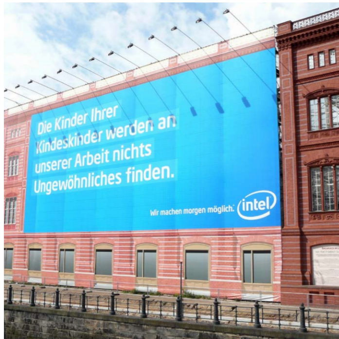
Bild 1: Berlin, Werderscher Markt – Bauakademie – Großflächenwerbungen eignen sich besonders für temporäre Aktionen. Im dargestellten Beispiel wird während der Sanierung des Gebäudes durch eine installierte Großflächenerbung eine intakte Fassade vorgetäuscht.
