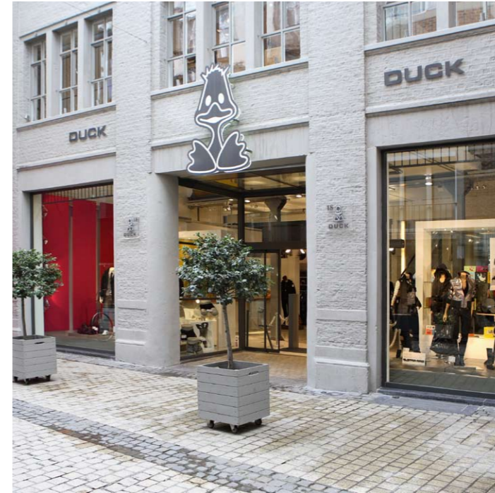
Bild 16: Lüttich, Rue Saint Adalbert 18 – Die grundsätzlich sehr positive Gestaltung der Erdgeschosszone wird dadurch beeinträchtigt, dass das Logo des „Entleins“ die Brüstungs- und Sturzbänder überdeckt und in die Öffnungen hineinragt. Eine Größenreduzierung auf weniger als die Hälfte würde hier eine Verbesserung bewirken.
