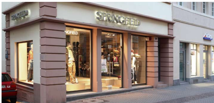
Bild 1: Heidelberg, Hauptstraße 89 – Hinterleuchtete Buchstaben stellen eine Variante dar, wie Schriftzüge von der Fassade räumlich abgerückt werden können. Es wird nicht die Schrift, sondern die dahinterliegende Fassadenfläche beleuchtet.
