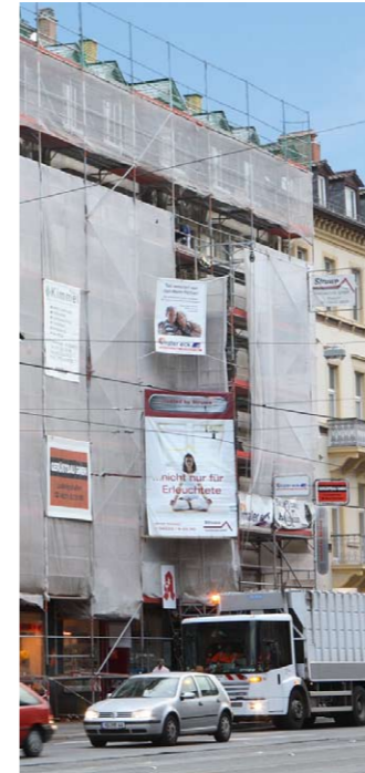
Bild 2: Ohne Ortsangabe – „Konzeptionslos“ auf Baugerüsten befestigte Einzelwerbungen sind unzulässig, weil diese während der Bauzeit zur Verunstaltung des städtebaulichen Umfeldes beitragen.
