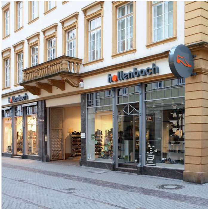
Bild 14: Heidelberg, Hauptstraße 73 – Obwohl der Erdgeschossumbau des historischen Gebäudes gelungen ist und sich die Werbeschriftzüge der Fassade unterordnen, ist die Auslegerwerbung zu groß, weil diese das Gesimsband im Brüstungsbereich des Obergeschosses und die Profilleiste im Sturzbereich des Erdgeschosses überdeckt. Ein Ausleger mit der Hälfte des Durchmessers würde die Werbewirkung nicht vermindern und die Gestaltung wesentlich verbessern.
