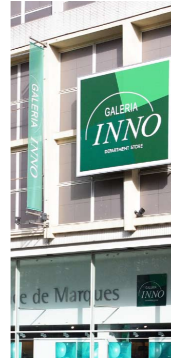
Bild 6: Lüttich, Place de la Republique Francaise 15 – Werbeflächen, die Fassadenstrukturen wie senkrechte Pfeiler überdecken, erfüllen nicht die Anforderungen der Satzung. Der Stadtraum soll durch die Gebäude und nicht durch die Werbeflächen geprägt werden.
