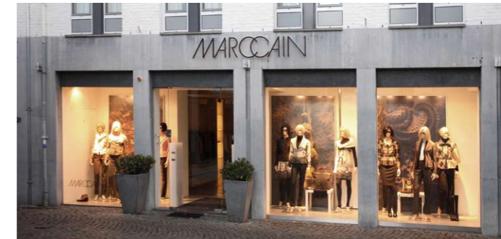
Bild 2: Maastricht, Plankstraat 23 – Sehr einfach und schlicht geschmiedete Buchstaben beeinflussen die Architektur des Gebäudes fast nicht. Die Fläche des Sturzbalkens der Kalksteinverkleidung eignet sich sehr gut für die Anbringung einer Schrift.
