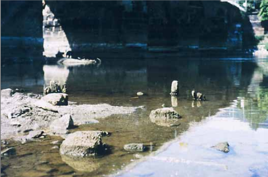
Ramppfähle im Flussbett bei Niedrigwasser (Fotos aus dem Jahr 2000)
