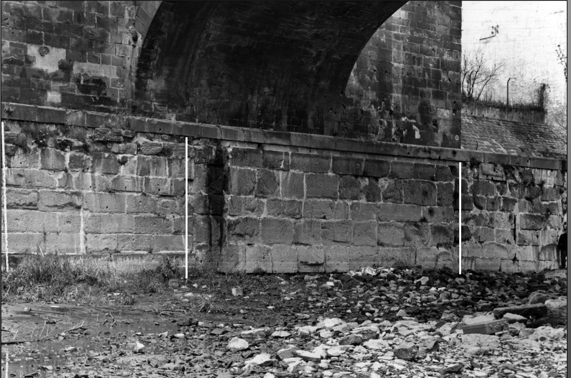
Römisches Brückenwiderlager aus Basaltquadern am Westufer (Foto von 1962)
