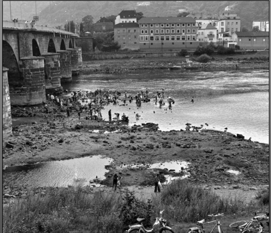
„Schatzsucher bei der Arbeit“ (1974) (tiefligender Wasserstand aufgrund von Schleusenarbeiten)
