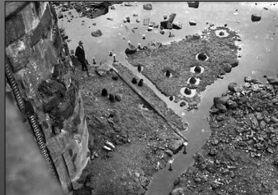
Spundwand Pfeiler 7 und Rammpfähle der Vorgängerbrücke bei Niedrigwasser (Foto: 1921)
