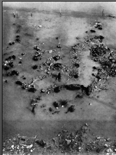
Pfahlrost der Vorgängerbrücke
