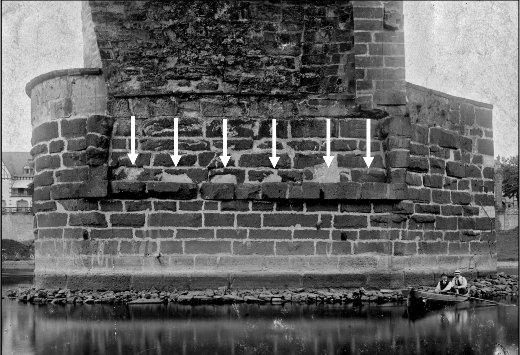
Längsseite eines Basaltpfeilers (Pfeiler 5 von Westen) mit Konsolbank und markierten sechs Einlasslöchern für Holzstreben (Foto von 1911)
