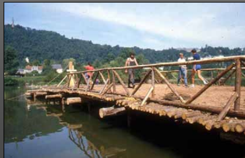
Nachbau einer Pfahljochbrücke an der Mosel (1985)
