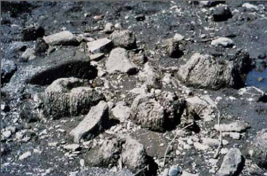
Ramppfähle im Flussbett bei Niedrigwasser (Fotos aus dem Jahr 2000)
