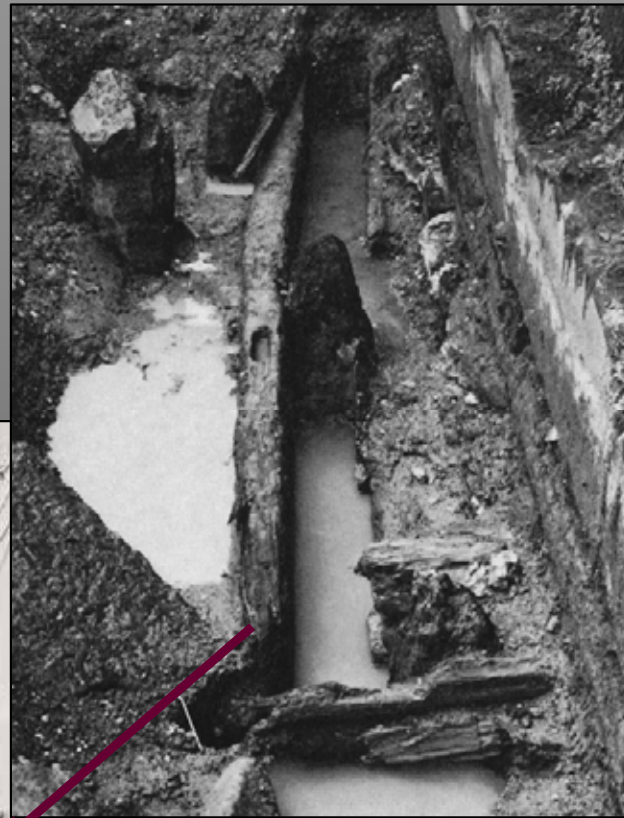
Spundwandverbau am westlichen Brückenkopf
