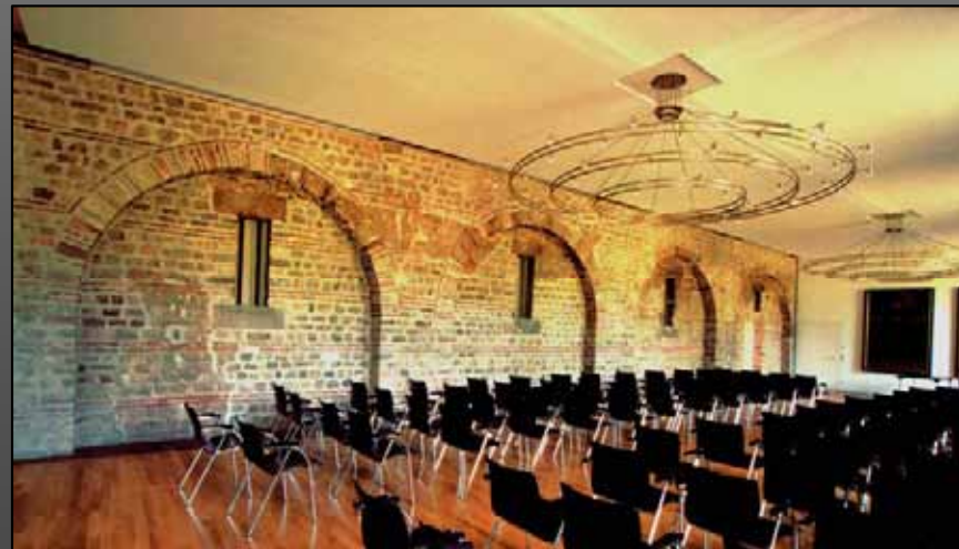
Außenwand des spätrömischen Speicherbaus im Obergeschoss der Vereinigten Hospitien
